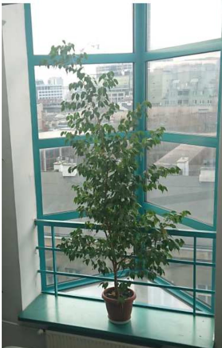
Fotografia 14 Wygląd okna na klatce schodowej od strony północno - zachodniej
