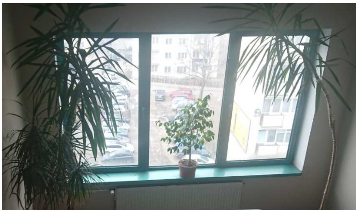
Fotografia 13 Wygląd okna na klatce schodowej od strony północno - zachodniej
