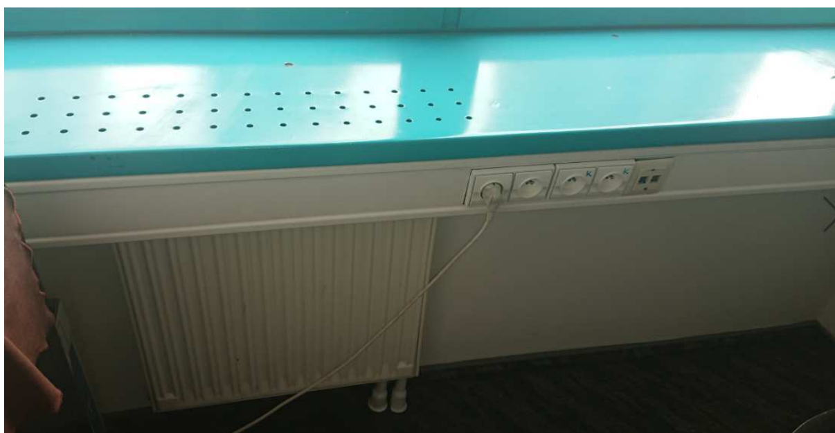
Fotografia 27 Koryto kablowe pod parapetem
