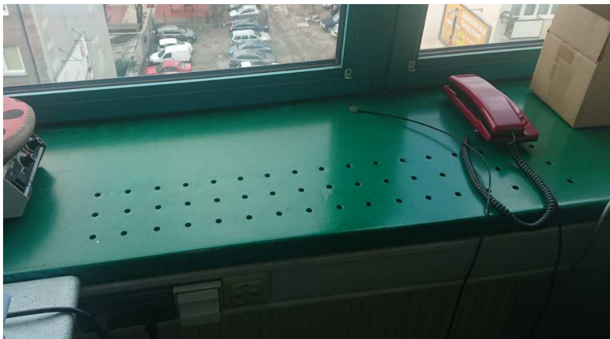
Fotografia 4 Wygląd typowego parapetu i listwy instalacyjnej w pomieszczeniu biurowym
