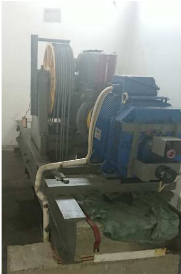
Fotografia 23 Napęd windy elektrycznej z szafą sterowniczą nr 1
