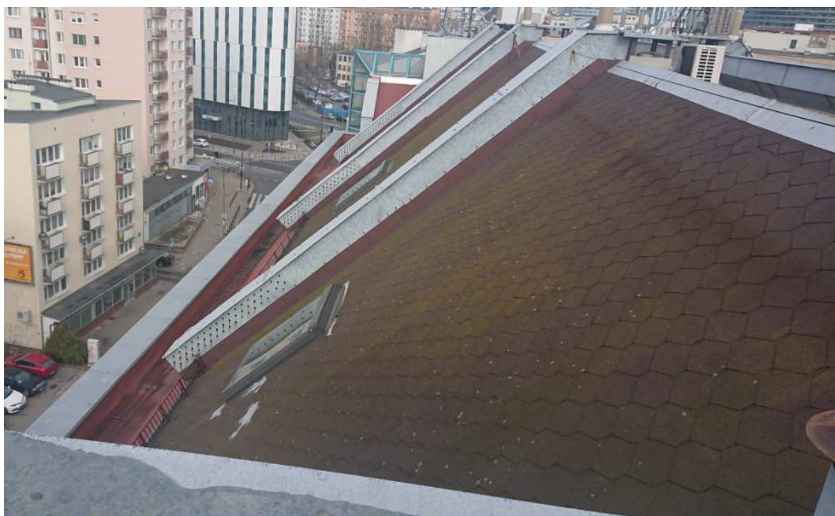
Fotografia 18 Wygląd okna na klatce schodowej od strony północno - zachodniej
