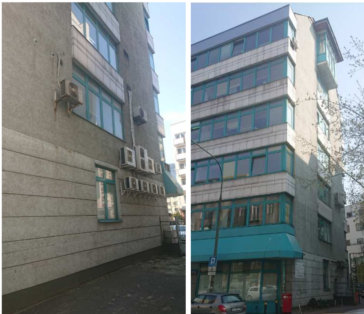
Fotografia 10 Elewacje północna i południowa
