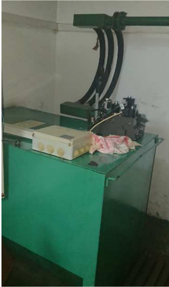
Fotografia 22 Wygląd napędu windy hydraulicznej z szafą sterowniczą.
