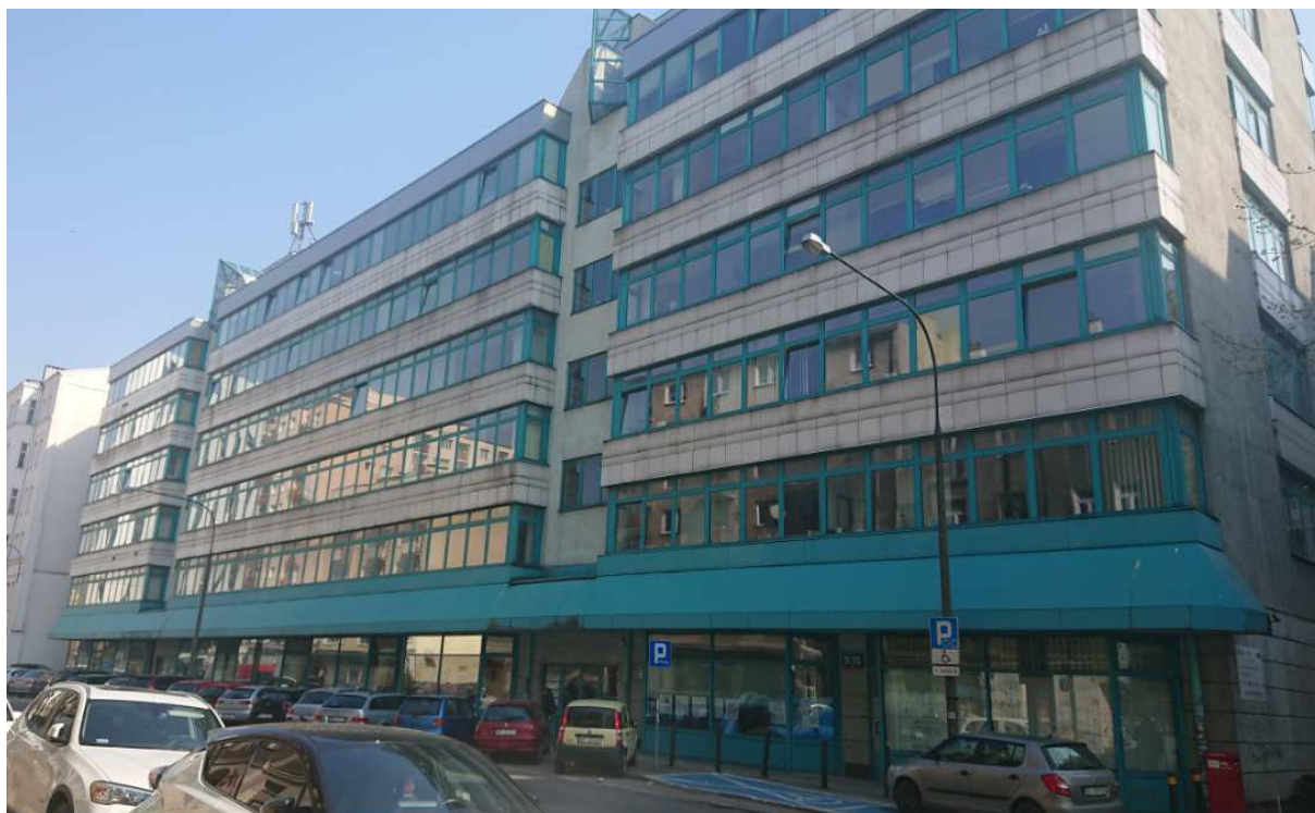
Fotografia 8 Elewacja północno - zachodnia
