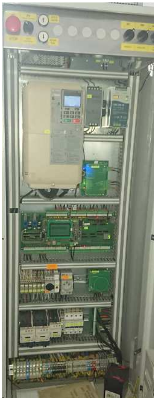
Fotografia 25 Szafy sterownicze wind nr 2 i 3
