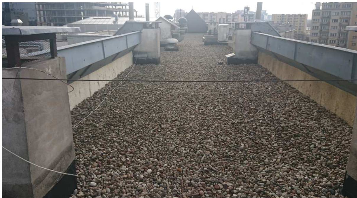
Fotografia 17 Wygląd dachu płaskiego
