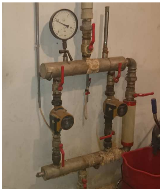
Fotografia 7 Pompy obiegowe instalacji c.w.u.
