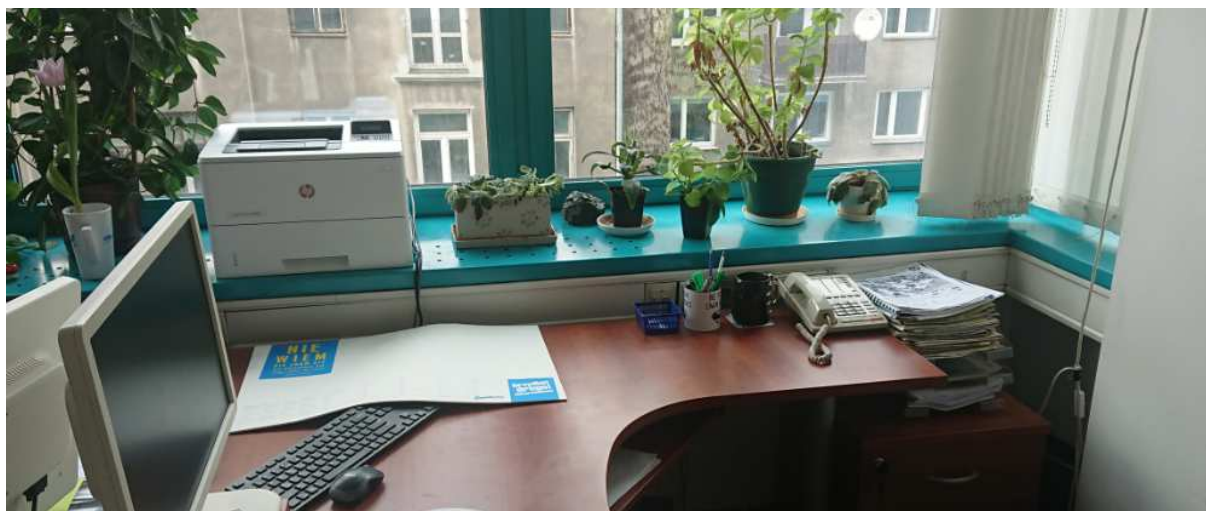
Fotografia 28 Koryto kablowe pod parapetem – c.d.
